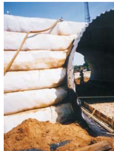
POWIĄZANIE NASYPU Z PRZEPUSTEM DROGOWYM
