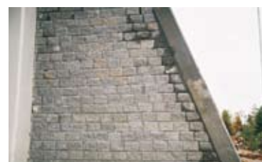
OSŁONA PRZYZCÓLKÓW Z BLOCZKÓW PREFABRYKOWANYCH
