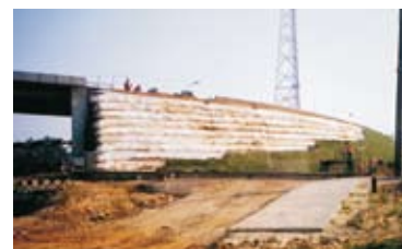
NASYP DROGOWY OD WSCHODNIEJ STRONY MOSTU
