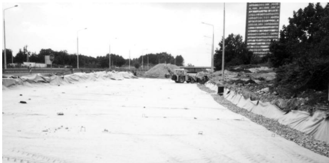
Rys. 4: Geowłóknina ułożona na całej powierzchni. Po prawej stronie odwodnienie 19 metrów szerokości pasa autostrady przy pomocy tzw. „drenu francuskiego”. (modernizacja wg technologii P.R. INORA® odcinka ul. Górnośląskiej [Katowice] w ciągu autostrady A-4 Katowice – Kraków, lipiec 1999 r.).
