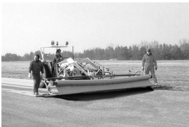
Rys. 5: Rozkładanie geowłókniny na warstwie nośnej związanej środkami hydraulicznymi.
