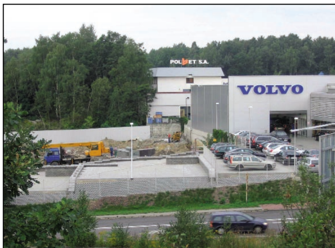
Fot. 3, 4. Ściana bierna – budowa tarasowych parkingów wystawowych przy salonie VOLVO w Katowicach.
