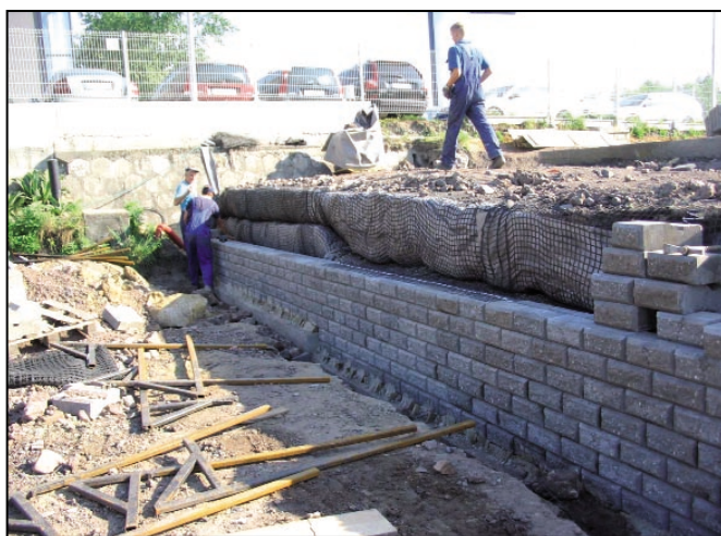
Rys. 2. Składowe elementy konstrukcji ściany biernej systemu Dermat® z siatkami Fortrac®.
