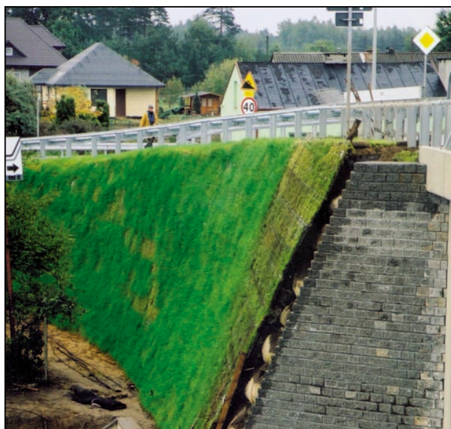
Fot. 6, 7. Ściana bierna – budowa węzła drogowego w miejscowości Huta Żabiowska – DK8.
