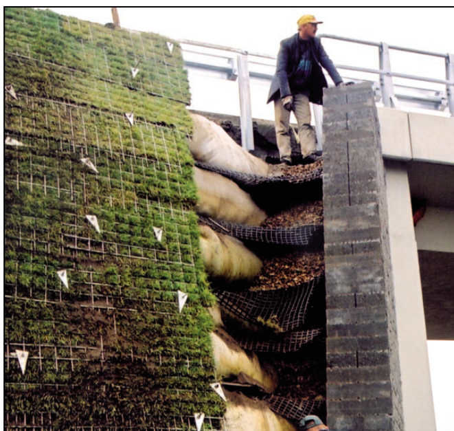
Fot. 6, 7. Ściana bierna – budowa węzła drogowego w miejscowości Huta Żabiowska – DK8.
