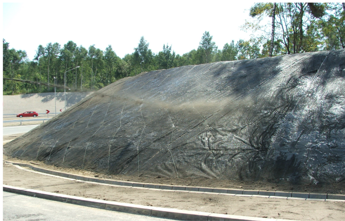
Fot. 11. Zabezpieczenie przeciwoerozyjne i zazielenienie skarp siatką HaTe® 23.142 w ciągu Autostrady A4 - Węzeł Batory
