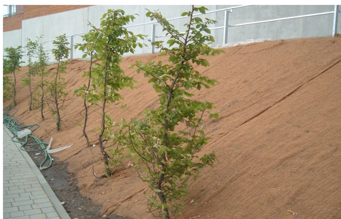
Fot. 2. Zabezpieczenie i zazielenianie skarp. Katowice Dębowe Tarasy
