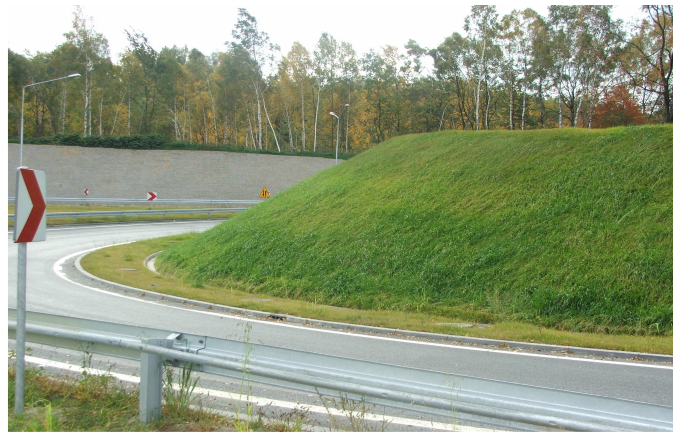
Fot. 12. Zabezpieczenie przeciwoerozyjne i zazielenienie skarp siatką HaTe® 23.142 w ciągu Autostrady A4 - Węzeł Batory
