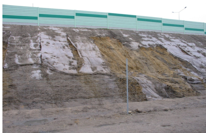
Fot. 6. Skarpa zabezpieczona biowłókniną. Autostrada A4, rok 2004/2005
