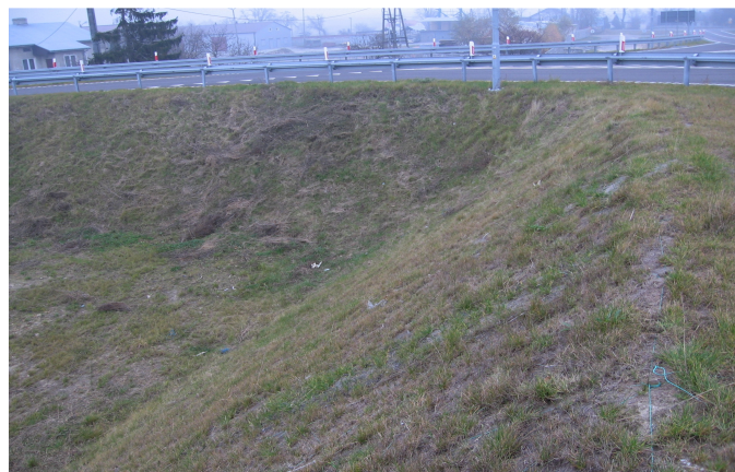
Fot. 4. Zabezpieczenie przeciwoerozyjne oraz zazielenienie skarp wiaduktu w miejscowości Piaski. DW 837
