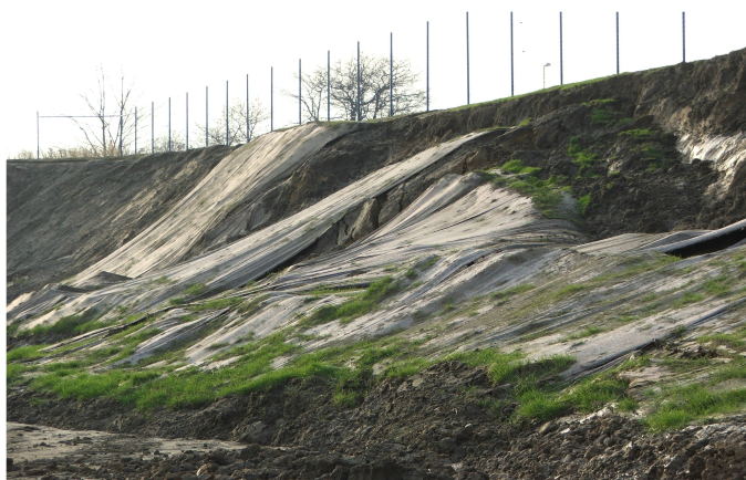
Fot. 5. Skarpa zabezpieczona biowłókniną. KSSE Gliwice, rok 2006
