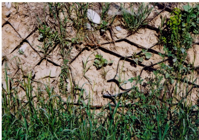
Fot. 7. Skarpa zabezpieczona geokrą
