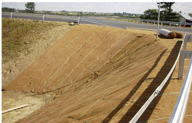
Fot. 3. Zabezpieczenie przeciwoerozyjne oraz zazielenienie skarp wiaduktu w miejscowości Piaski. DW 837
